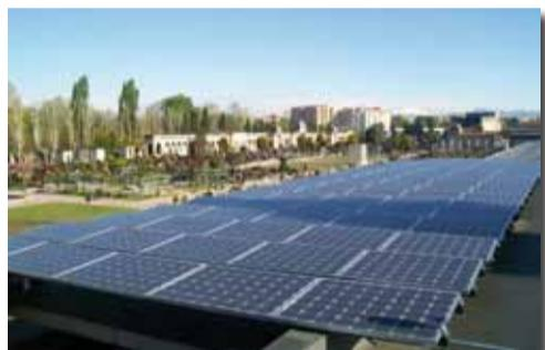
L'impianto fotovoltaico realizzato sul tetto del nuovo corpo G del cimitero è stato attivato nel mese di marzo del corrente anno ed è ora in piena attività con una potenzialità di 16,28 kWp il che permette di coprire i consumi di parte delle utenze del cimitero e, più specificatamente, equivale al consumo di tutte le lampade votive (circa 11 KW) più altri consumi.
