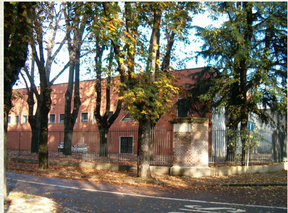
Ristrutturazione Palestra "Dozio"
